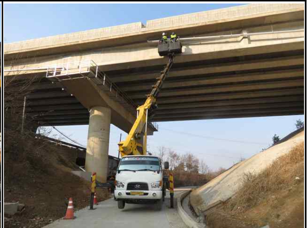
고소점검차를 이용한 바닥판 하부 조사
