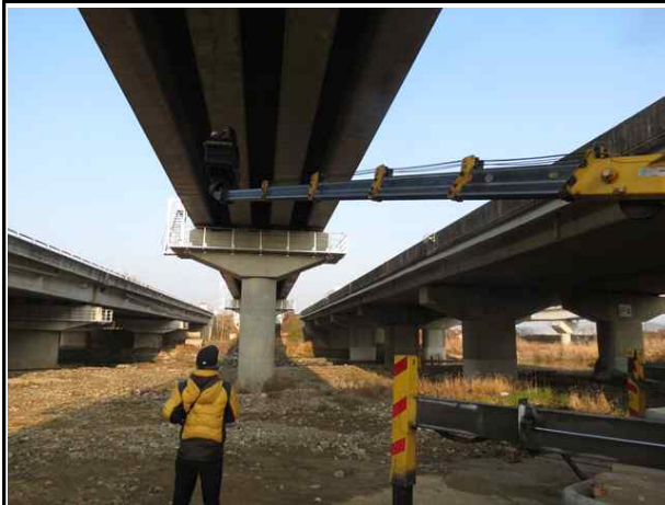
고소점검차를 이용한 바닥판 하부 조사
