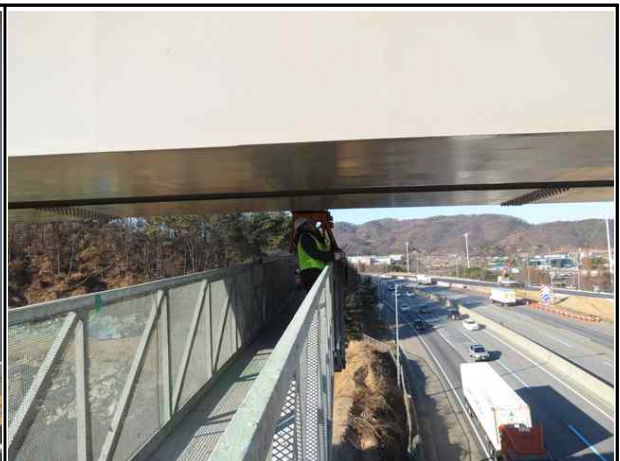
교량점검차를 이용한 바닥판 하부 조사
