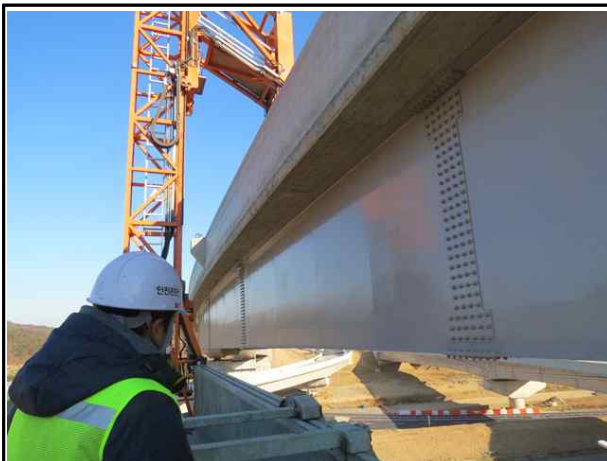
교량점검차를 이용한 바닥판 하부 조사
