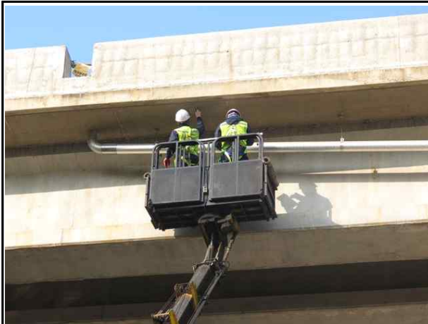
고소점검차를 이용한 바닥판 하부 조사
