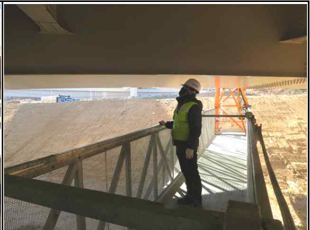
교량점검차를 이용한 바닥판 하부 조사
